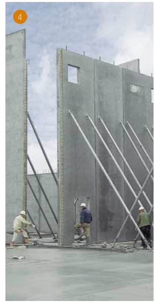
4 Vægelementer til et af råhusene på Factor VII i Hillerød.
