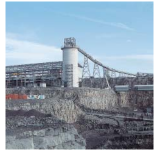
Opførelse af cementfabrik i Buxton, England.
